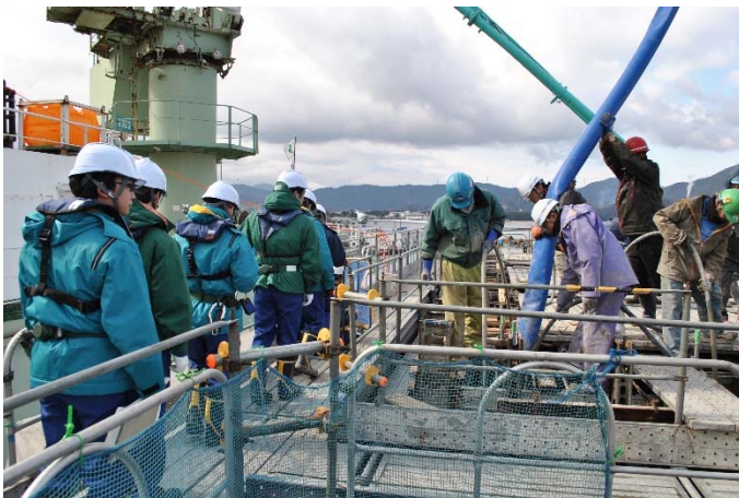
コンクリート打設を間近で見学！
