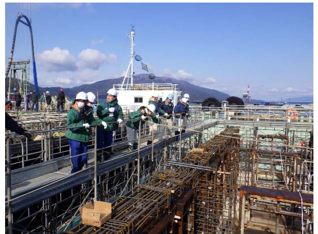
鉄筋組立状況の見学
