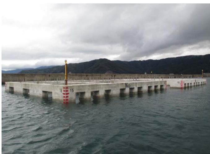
2函仮置き後、標識灯設置し、止水板を取外し
