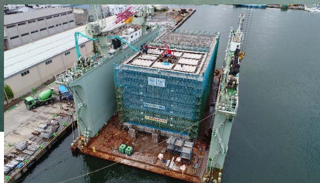
製作中のケーソン（2,137t/函、B12.9m×L15.0m×H15.5m）
