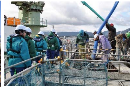
コンクリート打設を間近で見学
