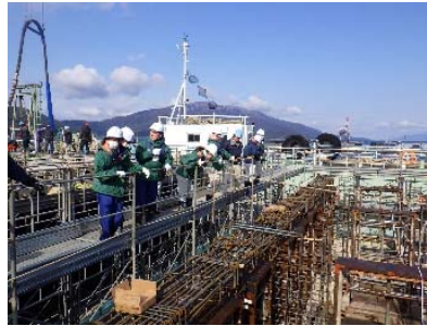
鉄筋の組み立て状況を見学
