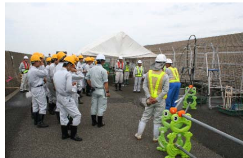
昨年の地盤改良機材の実演状況
