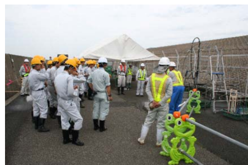
地盤改良機材の実演状況
