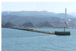
先端のケーソンと消波ブロックが据わって、全体像が見えてきた敦賀港鞠山防波堤
