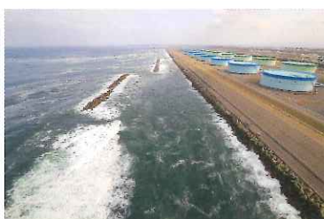
波が潜堤で砕け、護岸に到達する波が抑制されている様子
