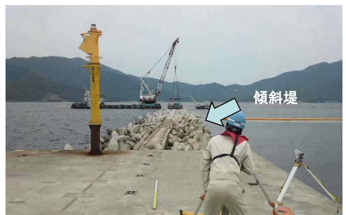
ケーソン据付作業中
