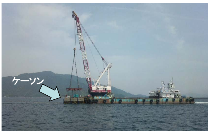
曳航中の最終ケーソン
