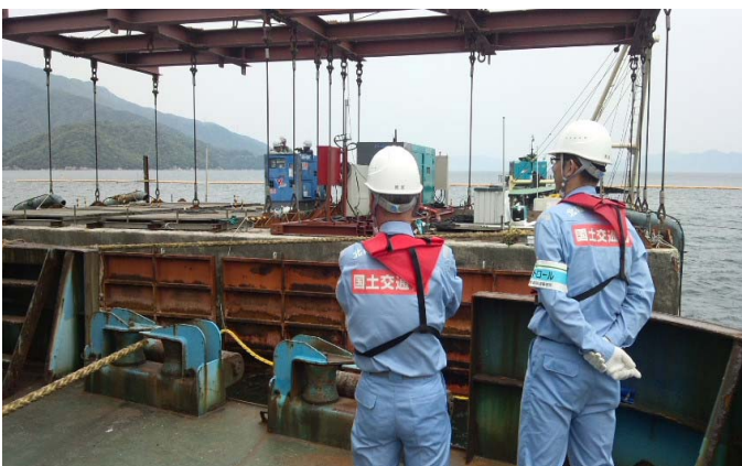
吊り下げられたケーソンの近影
