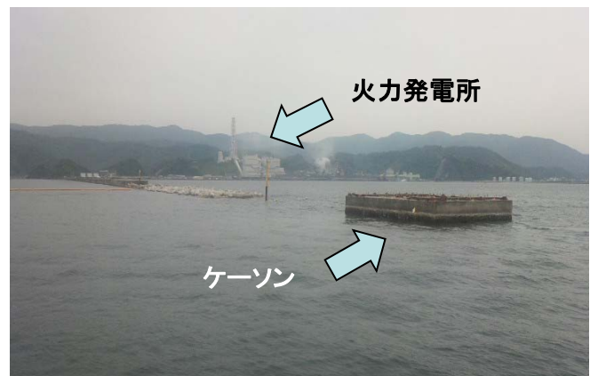
据え付けた最終ケーソンより基部を望む
