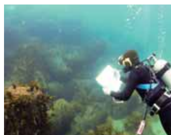
潜水士による海底構造物の調査
