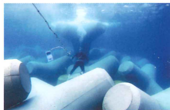
消波ブロック据付状況(水中より)
