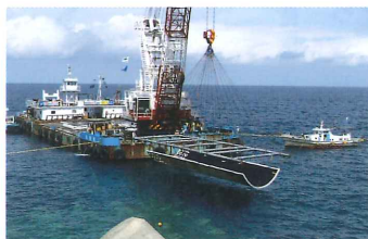
アスファルトマット敷設状況
