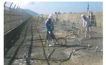
薬液注入状況
