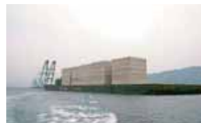
大型台船で福井港から海上輸送されるケーソン
