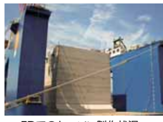
FDでのケーソン製作状況
