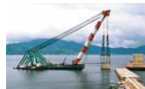
大型海上クレーンで所定の位置へ据付られるケーソン
