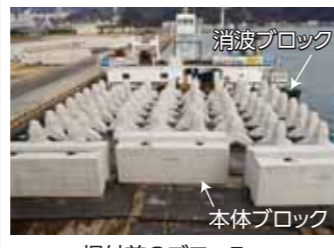
据付前のブロック
