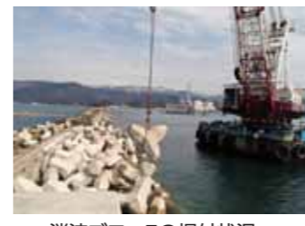
消波ブロックの据付状況
