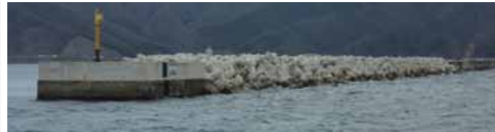
堤頭函と消波ブロック傾斜堤
