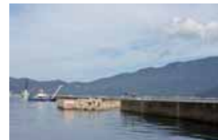
防波堤通水部
