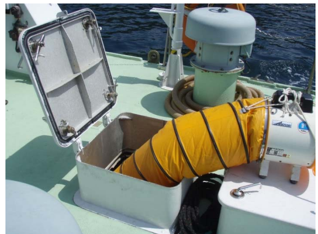
長距離の機関室高熱防止のため、送風機設置
