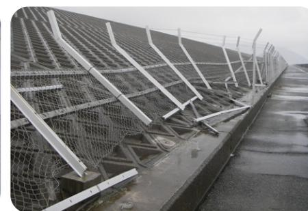
冬季の高波浪により、護岸背後の吸出し・陥没、国家石油備蓄基地施設の破損が頻発していた。
