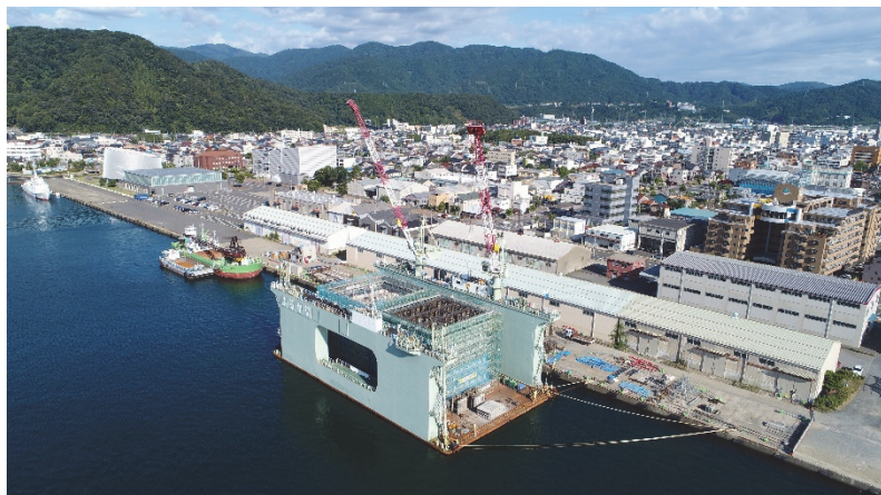
ケーソン製作は順調。9月上旬の進水を目指し、安全作業を徹底します。
