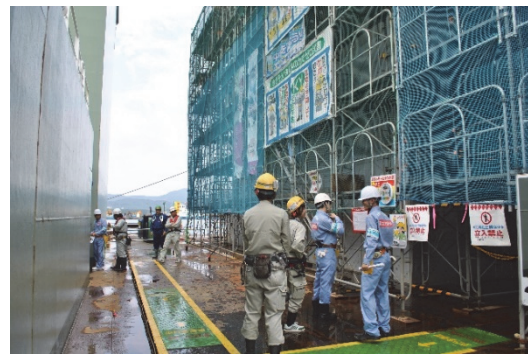
安全パトロールで事故を未然に防ぎます。
